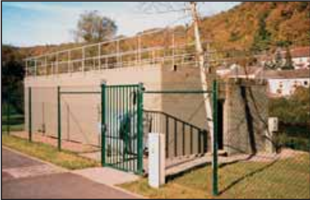
Abwasserentsorgung der Gemeinde und des Campingplatzes Wallendorf (Luxemburg) Mischsystem, 600 EGW
